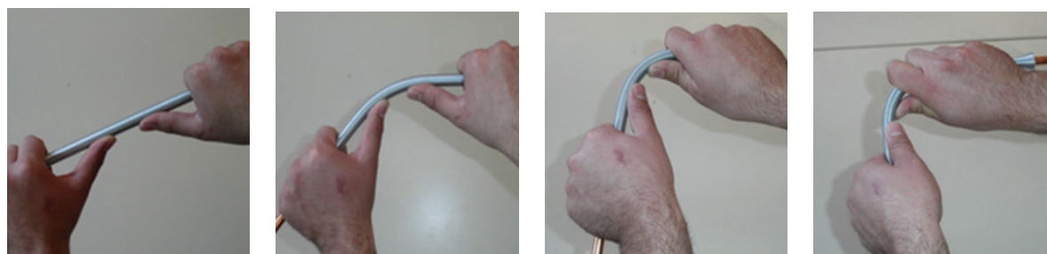
Slika 10.16: Koraci prilikom savijanja cijevi oprugom
