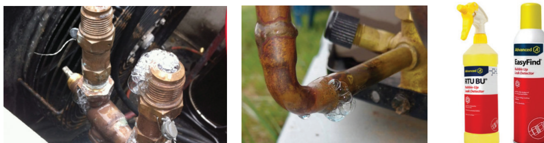
Slika 4.5: Provjera propuštanja korištenjem testa sapunicom i mjehurićima
