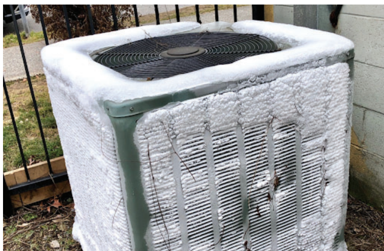
Slika 8.9: Potpuno zaleđeni isparivač kod toplotne pumpe u režimu grijanja
